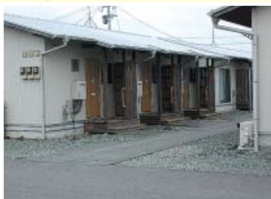
村営住宅へ改修待ちの木造仮設住宅
