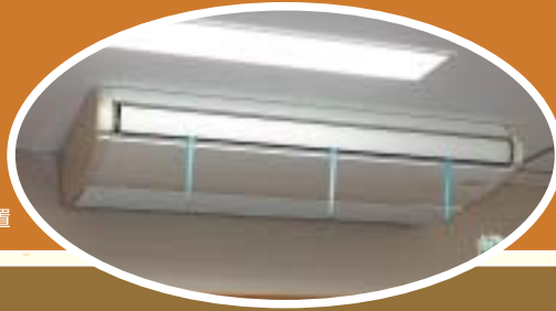
待ちわびたエアコン設置
