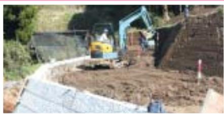
風当地区の工事現場
