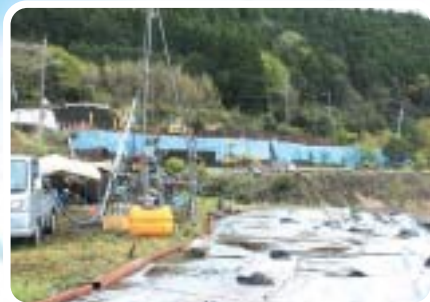
布田地区の集落再生工事
