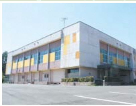
老朽化したトレーニングセンター
