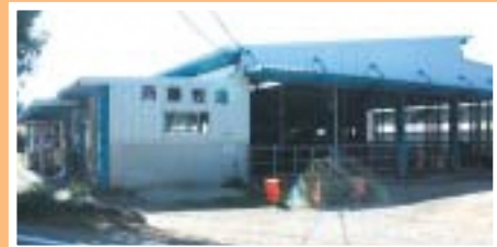
完成した牛舎
