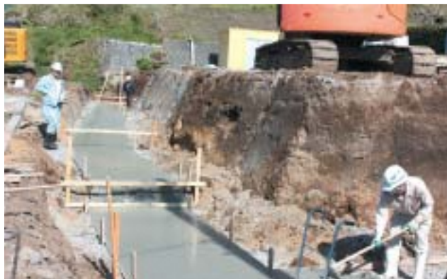
畑地区の集落再生工事
