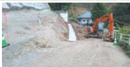
通行止めの工事現場
