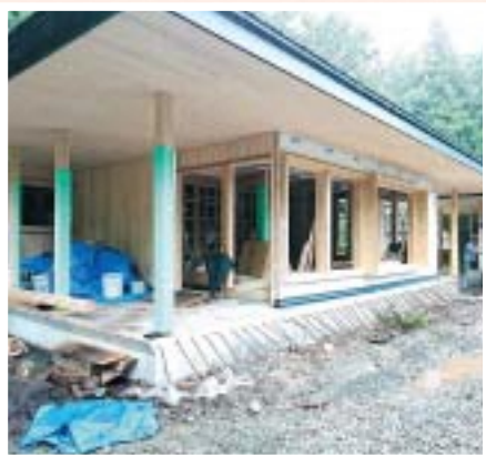
交付金で改修工事が出来た棟
