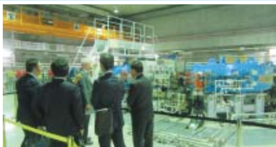
陽子線発生加速装置
