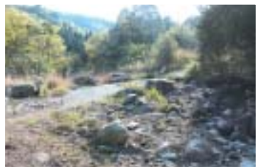
改修が必要な横断路
