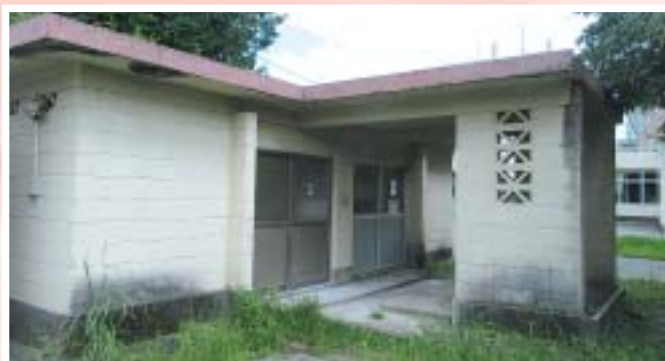
着工を待つ中学校・小学校の防災機能を兼ねた 屋外防災施設トイレ
