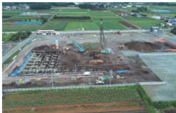
総合体育館建設着工
