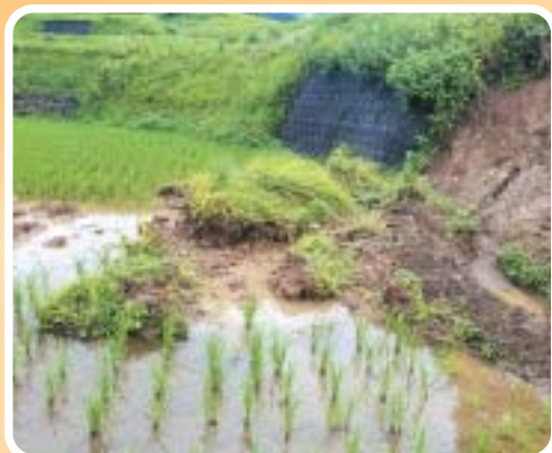
農地被害／瓜生迫（水路）河原付近
