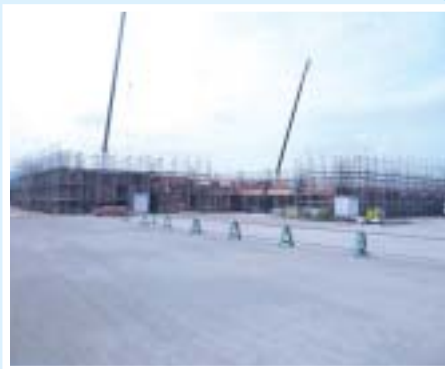
建設中の総合体育館
