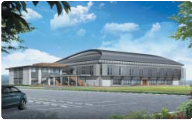
建設中の総合体育館
