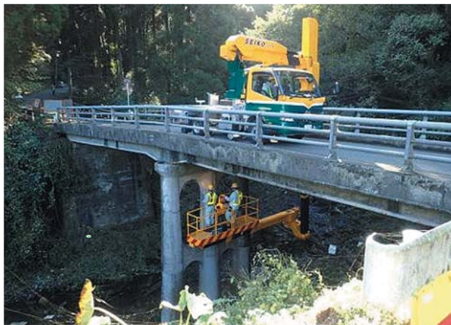
橋梁点検作業（龍口橋）
