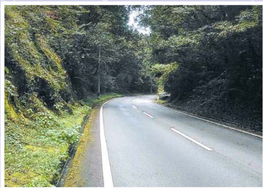
大規模林道の支障木
