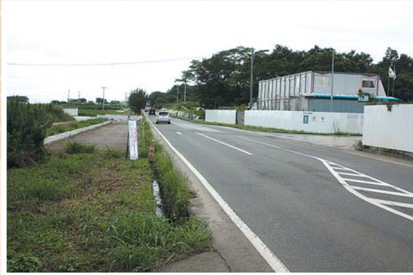
拡張工事中の東海大学前
