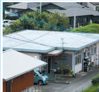
たんぼハウスの屋根修理
