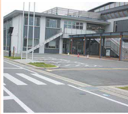
夜間の進入が心配される進入口
