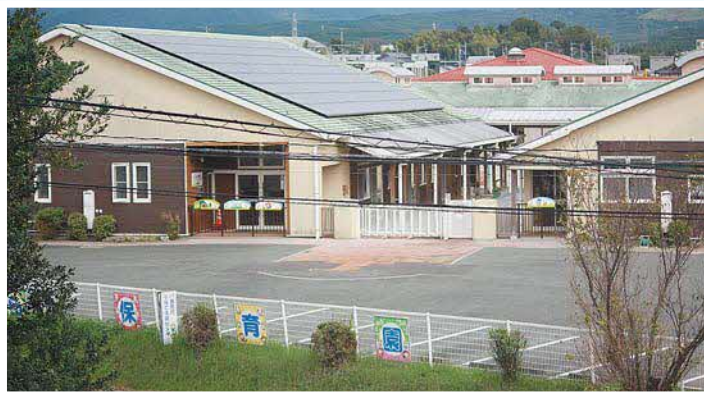
劣化が進む保育園
