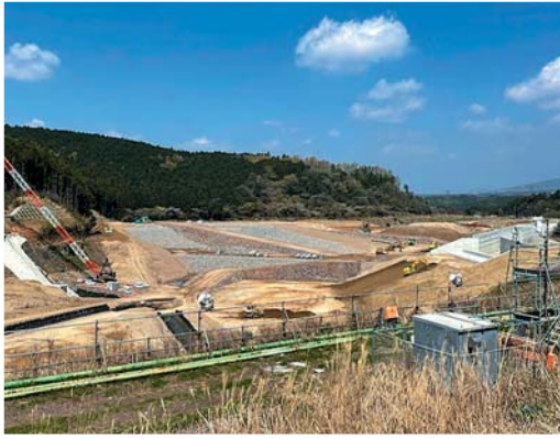
大切畑ダムの堤体
