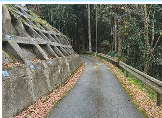
滝小野線道路改良箇所の一部
