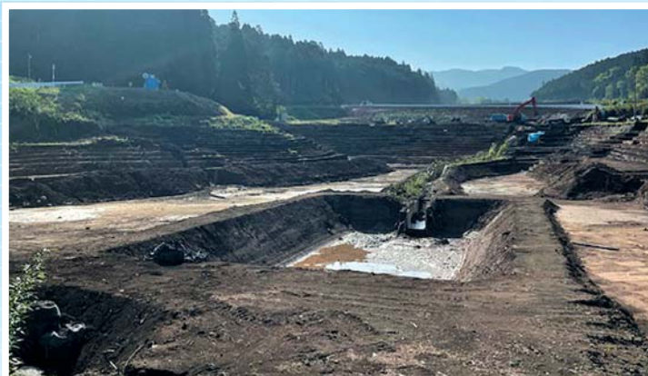
新工業団地調整池(工事中)
