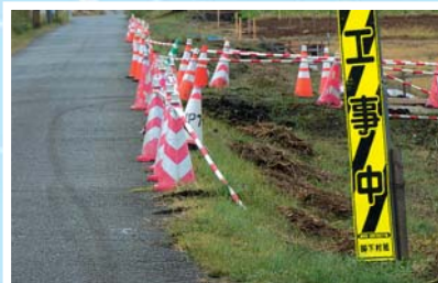
工事中的下新所下原3号線
